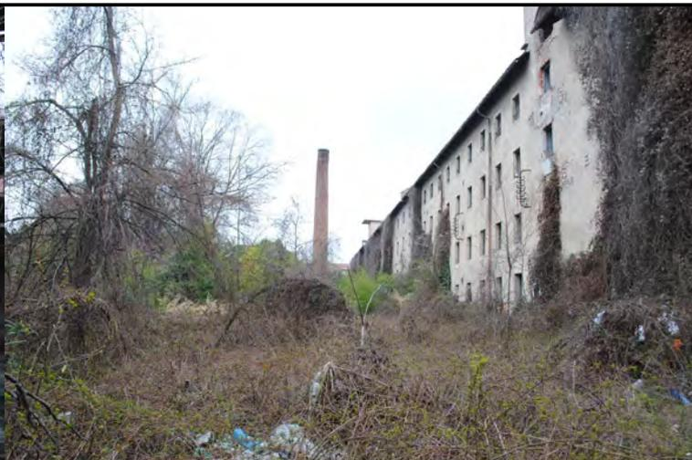
Pulitura delle parti di muratura conservate (ciminiera, tratti di muretti interni e del fronte sul Moirano) con azioni di rabboccatura e riscagliatura della muratura in pietra, opere di cuci-scuci delle parti deteriorate
