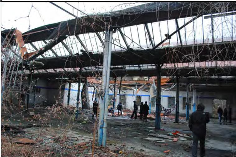
Rimozione delle parti pericolanti e non di pregio con evidenza delle strutture che costituiscono il weingrill con pulizia e verniciatura delle parti in metallo da conservare
