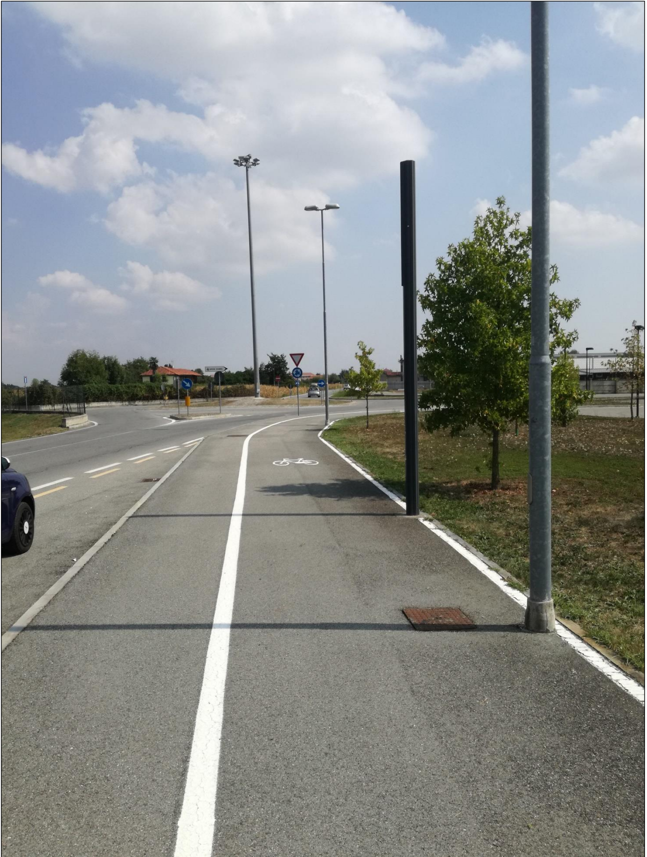
Figura 4 La rotonda di accesso all'area
