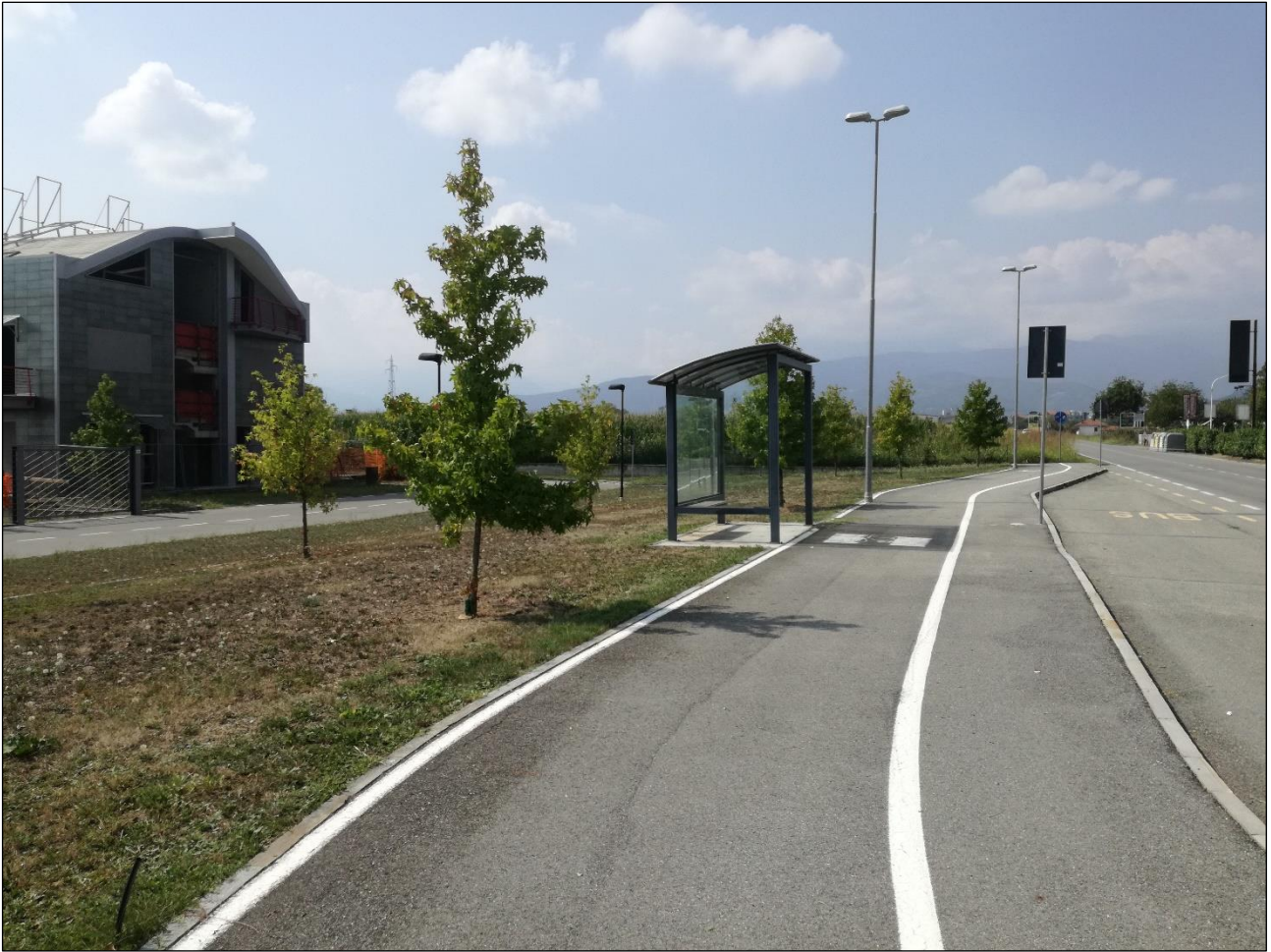
Figura 3 fascia dei servizi già realizzata su Via Pinerolo
