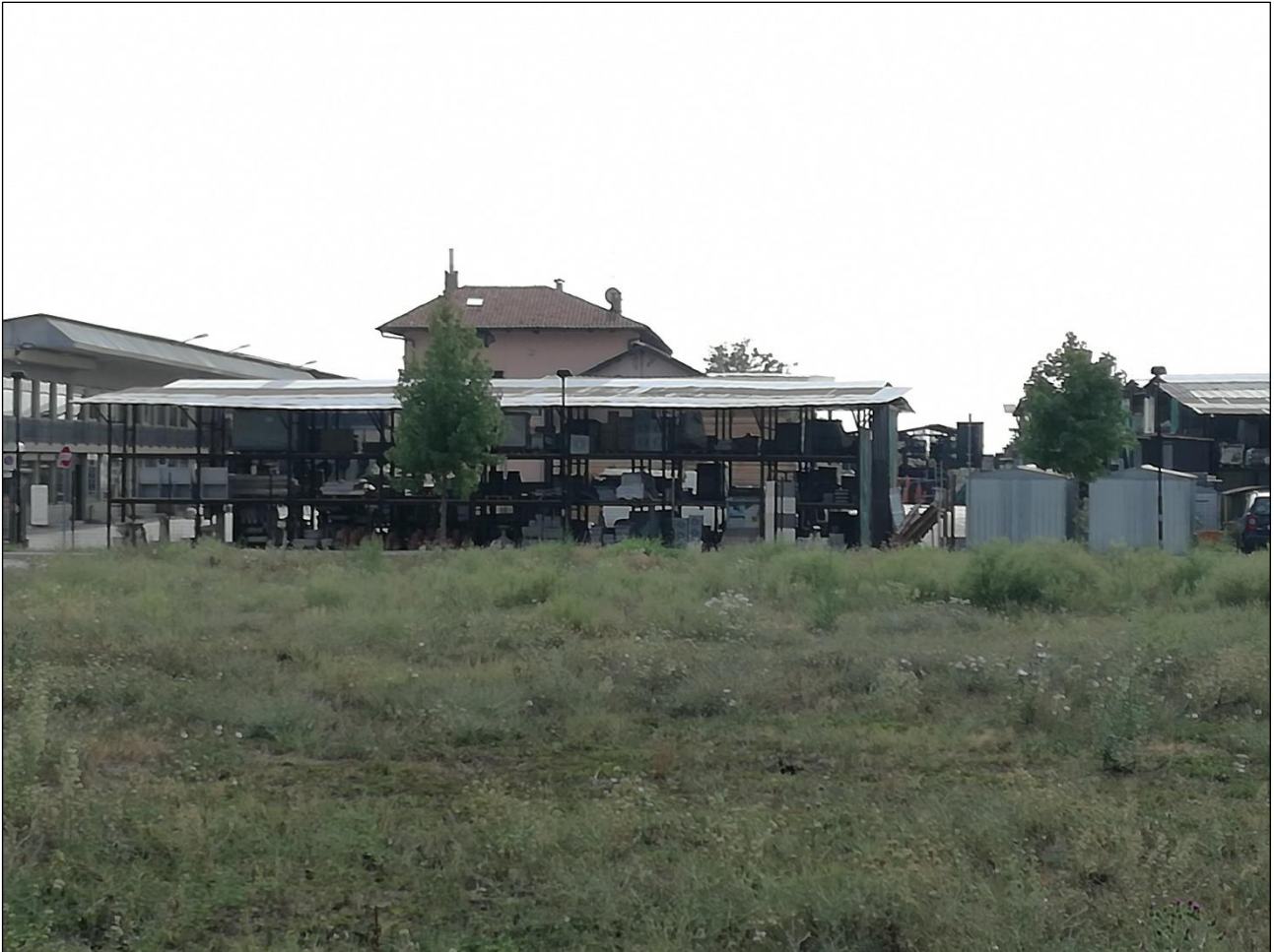
Figura 2 Edifici condonati di cui è prevista la demolizione
