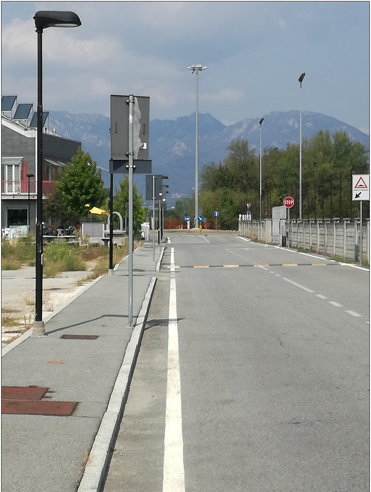
Figura 8 Strada di penetrazione interna
