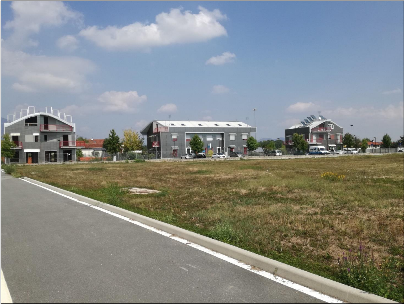
Figura 6 Edifici già edificati fronte interno
