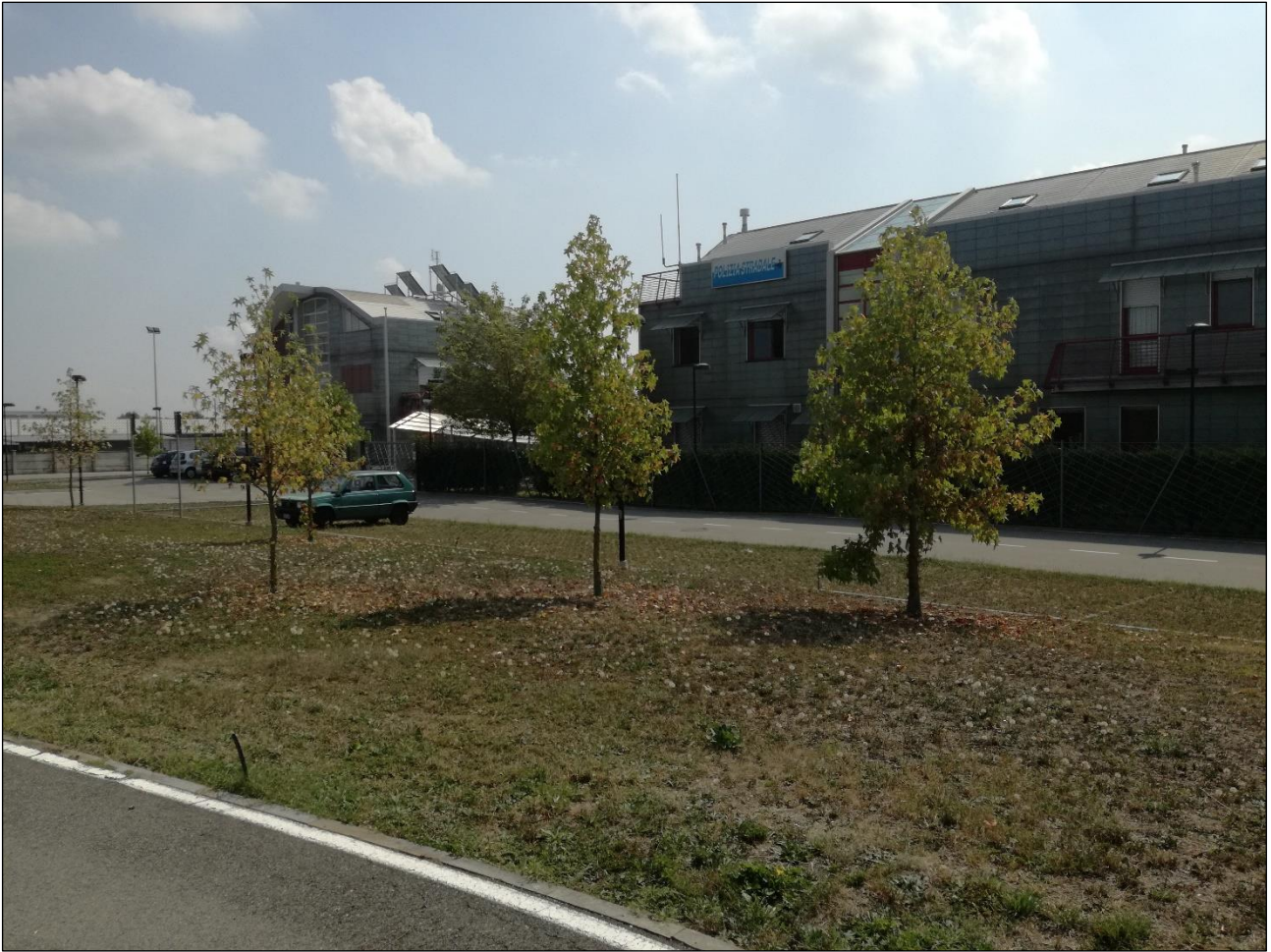
Figura 2 Edifici lotto L1 già realizzati su Via Pinerolo
