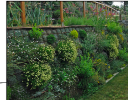
consolidamento in terra armata
