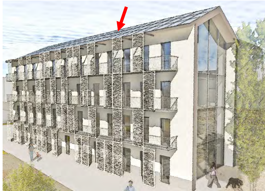
Facciata lato Sud
