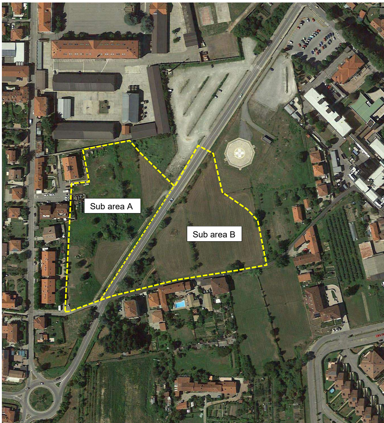
Fotografia aerea stato attuale
