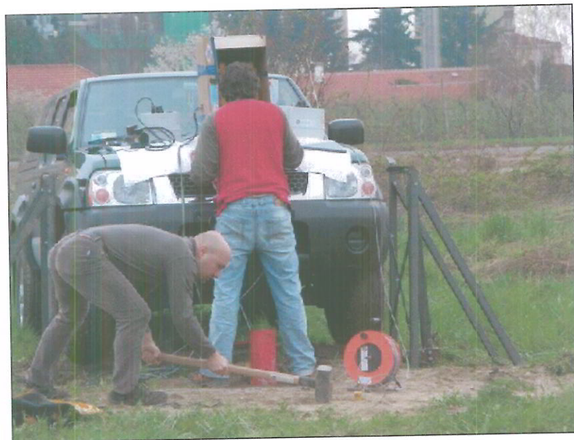
Foto 4: Fase di energizzazione con massa battente in direzione verticale.
